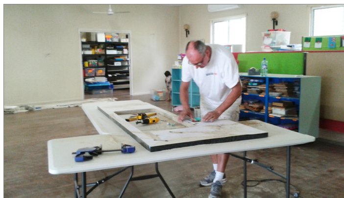
Kuchnia nowa, ale jej wszystkie elementy trzeba było najpierw poskładać, potem dociąć i dopasować blaty, no i później oczywiście zamontować.
