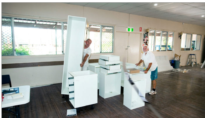
Kuchnia nowa, ale jej wszystkie elementy trzeba było najpierw poskładać, potem dociąć i dopasować blaty, no i później oczywiście zamontować.
