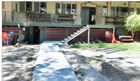
Zmieniono granicę przedszkolnego terenu i wbetonowano słupki pod nowe ogrodzenie. Przedszkole będzie miało całkiem osobne wejście z nowo-wybetonowaną ścieżką i nową bramą. Otrzyma również nowe schody i nową barierę ogrodzeniową wzdłuż przedszkolnego tarasu.
