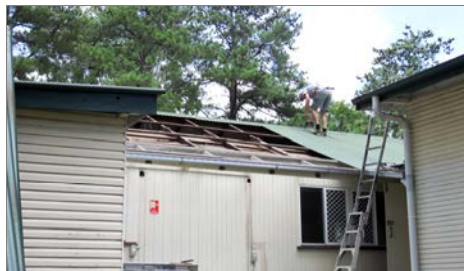
Stary dach budynku został częściowo rozebrany i odzyskana blacha zostanie wykorzystana przy pracach remontowych w klubie.
