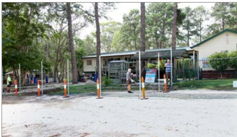
Zmieniono granicę przedszkolnego terenu i wbetonowano słupki pod nowe ogrodzenie. Przedszkole będzie miało całkiem osobne wejście z nowo-wybetonowaną ścieżką i nową bramą. Otrzyma również nowe schody i nową barierę ogrodzeniową wzdłuż przedszkolnego tarasu.
