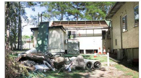
Stary dach budynku został częściowo rozebrany i odzyskana blacha zostanie wykorzystana przy pracach remontowych w klubie.
