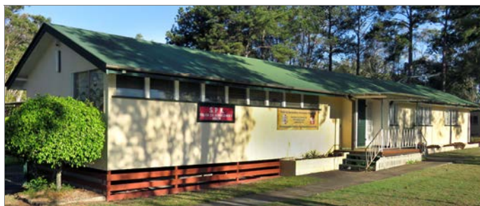
Tak wyglądał Dom Kombatanta przed wyburzeniem w grudniu 2017 roku.
